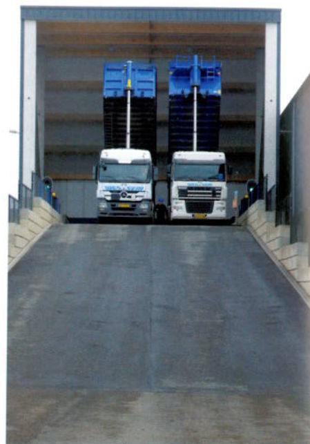
Afb. 2 Trucks rijden een vijf meter hoge oprit op, waar de lading wordt gekiept in een storttrechter
