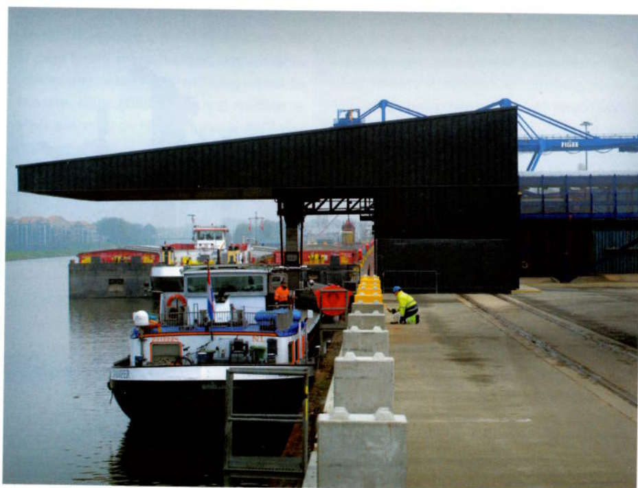
Afb. 1 De barge loader in de haven van Stein kenmerkt zich door een overkapping die het mogelijk maakt schepen onder alle weertypes te beladen
